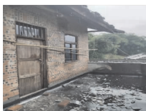
图11 古佛镇天洋村砖木结构房屋梭瓦
