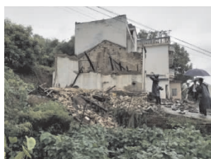
图3 福集镇草坝村砖木结构房屋倒塌
