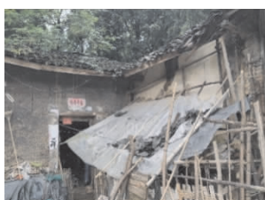
图10 得胜镇门斗山村土木结构房屋梭瓦
