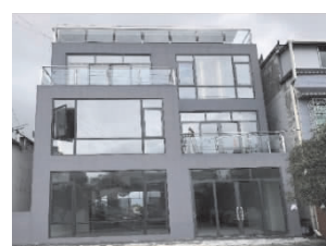
图13 玉蟾街道龙华村框架结构房屋基本完好
